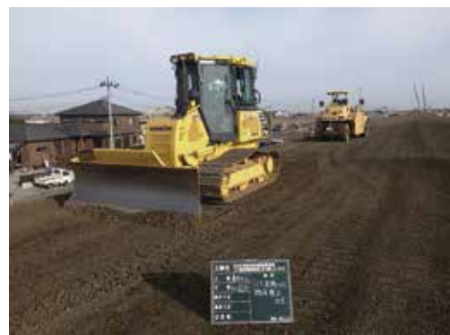
写真-6 敷均し状況
