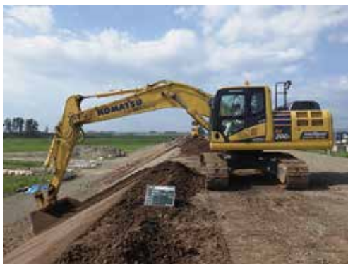
写真-3 マシンコントロール油圧ショベル法面整形状況
