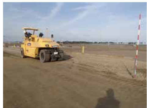
写真-1 GPRoller転圧状況
